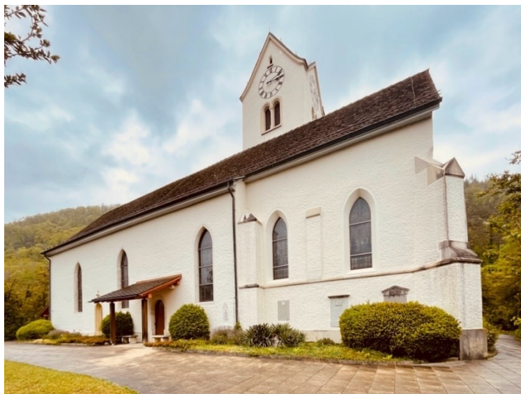
Abbildung 4: Ansicht von Süden
